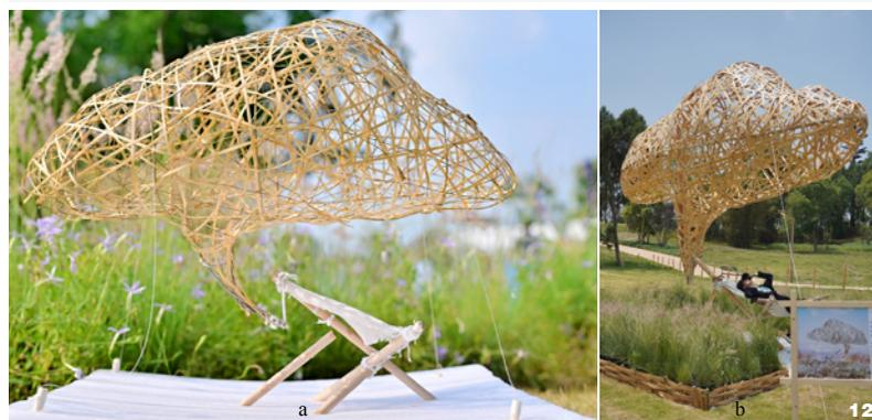
图11 “云山浮蓉”花园中的张拉结构分析
