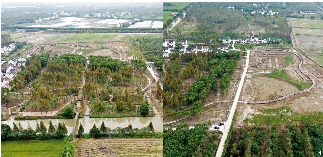
1. 建设中的廊下郊野公园二期农林水乡
