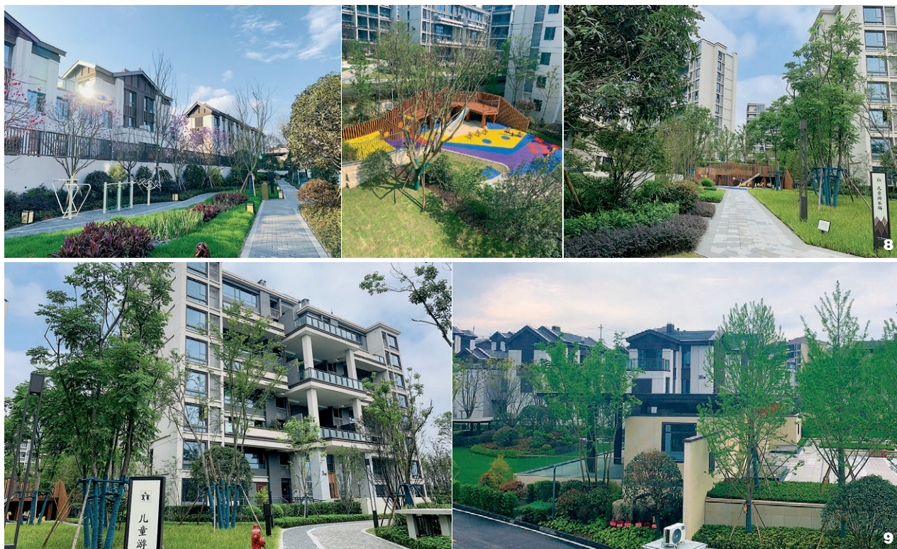
8. 已建成部分公共设施与绿廊有机串联实景图（资料来源：重庆两江新区开发投资集团有限公司） 9. 单体建筑风貌实景图（资料来源：重庆两江新区开发投资集团有限公司）
